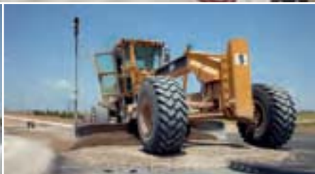
KM 150 Nivellement en cours avec une niveleuse 16H.
