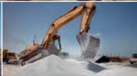
KM 152 Une pelle hydraulique déplace la pierre pour préparer l'épandage.
